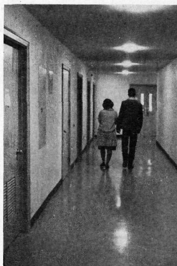
Bright halls replace drab interior.
